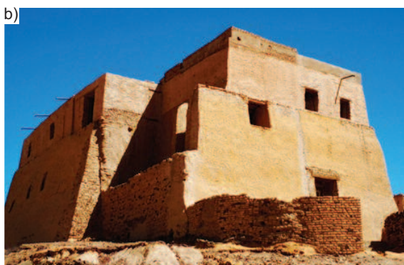
Stone walls on earth-based mortar (a), Tanais (Russia); mosque made of dried bricks on earth-based mortar (b), Old Dongola (Sudan) Mury kamienne na zaprawie glinianej (a), Tanais (Rosja); meczet z cegły suszonej na zaprawie glinianej (b), Old Dongola (Sudan)
