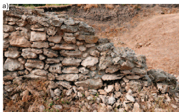
Stone walls on earth-based mortar (a), Tanais (Russia); mosque made of dried bricks on earth-based mortar (b), Old Dongola (Sudan) Mury kamienne na zaprawie glinianej (a), Tanais (Rosja); meczet z cegły suszonej na zaprawie glinianej (b), Old Dongola (Sudan)
