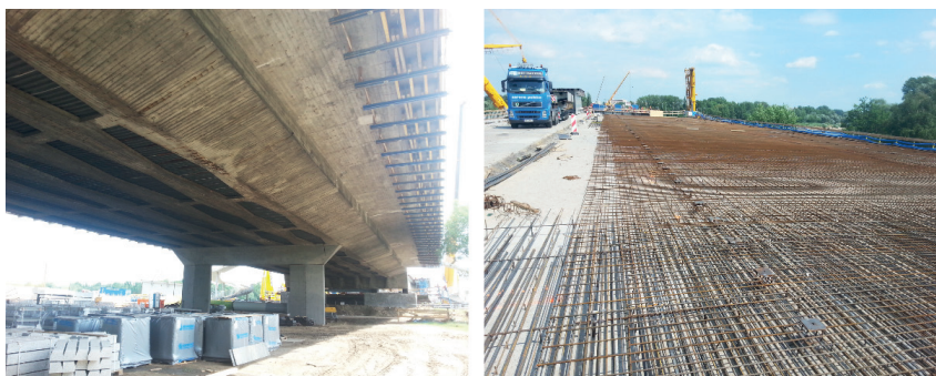
Photo 1. The Lazienkowski Bridge approach section during renovation Fot. 1. Płyty estakad dojazdowych mostu Łazienkowskiego podczas remontu
