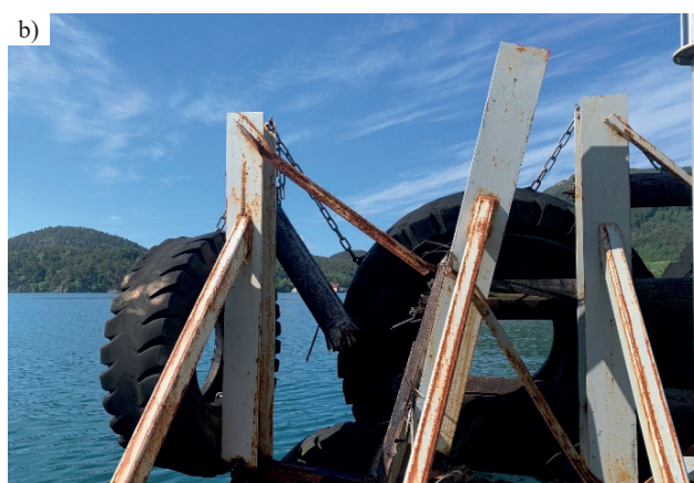
Photo 1. Ferry quay in Norway: a) ramp and pier; b) damage and wear of the infrastructure requiring modernization Fot. 1. Nabrzeże promowe w Norwegii: a) rampa i pomost; b) uszkodzenia i zużycie infrastruktury wymagającej modernizacji
