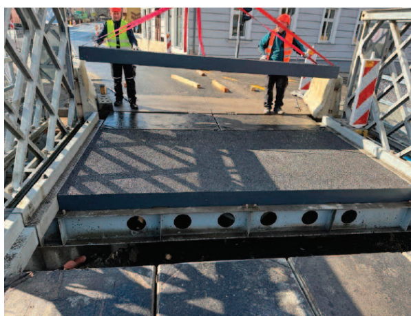
Photo 3. Laying composite bridge panels on a crossing made of a DMS-65 folding bridge structure after the flood in 2024 [21] Fot. 3. Układanie kompozytowych płyt pomostu na przeprawie wykonanej z konstrukcji mostu składanego DMS-65 po powodzi w 2024 r. [21]
