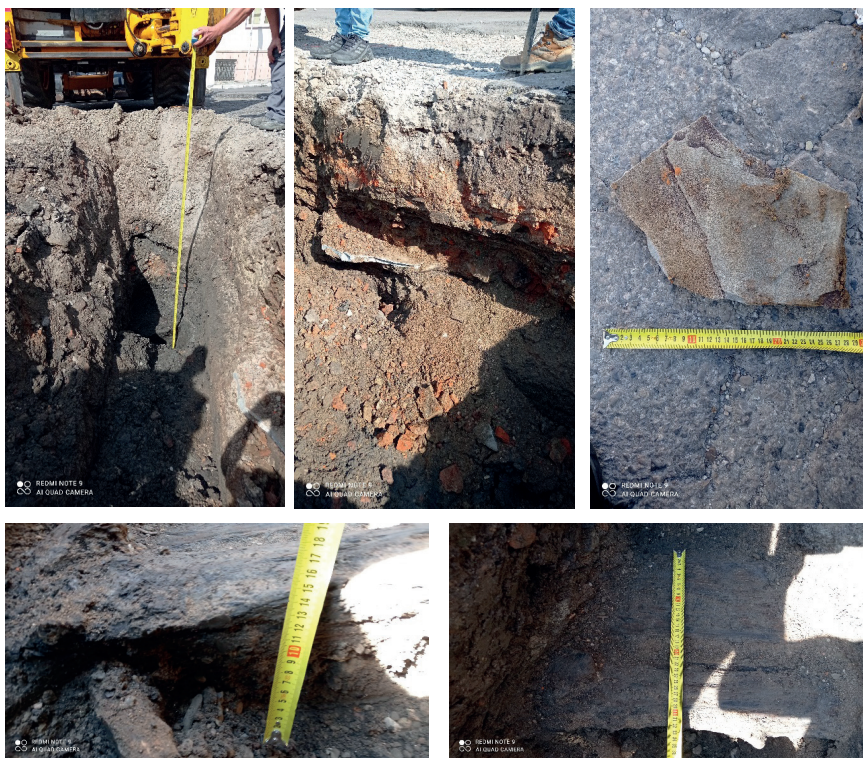
Photo 3. Excavation at the location of the detected anomaly Fot. 3. Odkrywka w miejscu występowania anomalii
