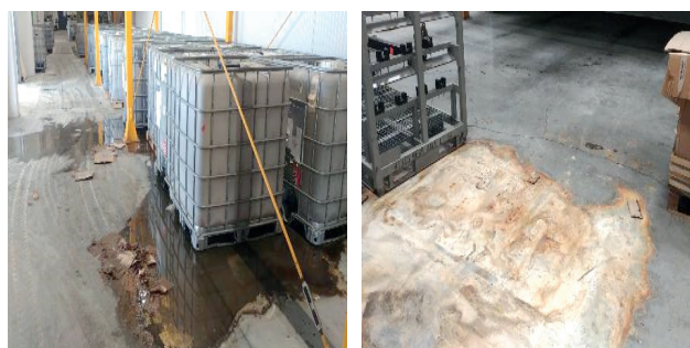
Photo 4. Examples of contamination on floor surfaces Fot. 4. Przykłady zanieczyszczenia powierzchni posadzki
