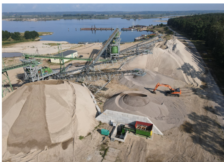
Typical sand processing plant Typowa wytwórnia piasku
