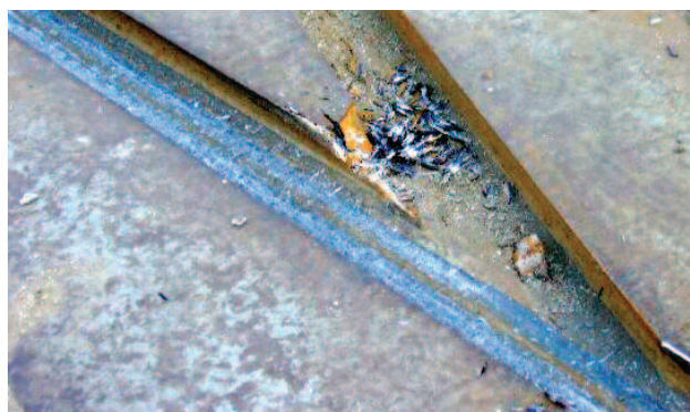
Photo 2. Traces of shearing and chipping on the frog nose Fot. 2. Ślady ścinania oraz wykruszeń dziobów krzyżownic
