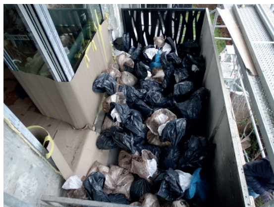
Photo 1. Load on the balcony at stage 4 Fot. 1. Obciążenie balkonu w etapie 4
