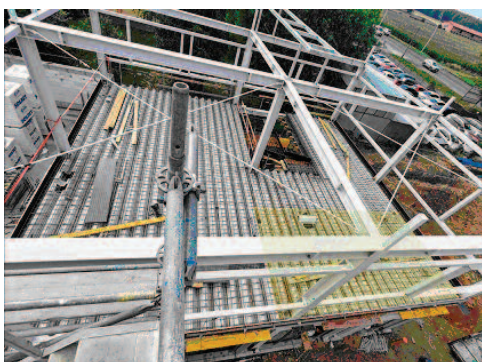
Photo 1. The ceiling before the concrete mix was laid Fot. 1. Strop przed ułożeniem mieszanki betonowej
