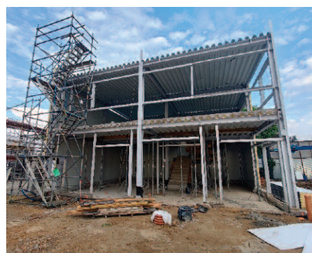
Photo 2. The office building under construction Fot. 2. Budynek biurowy w trakcie realizacji
