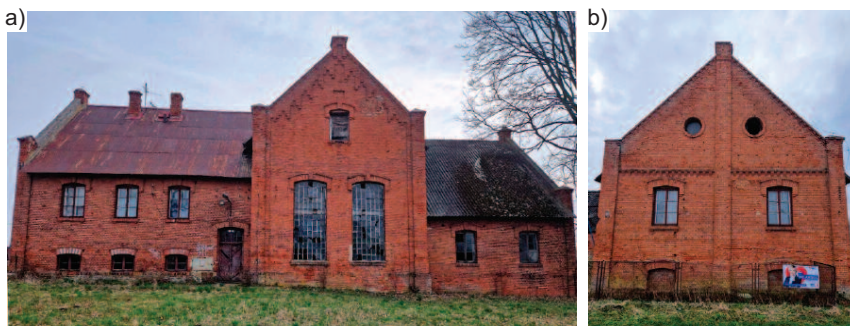
Old Distillery Building – west (a) and north (b) elevation Budynek Starej Gorzelnii – elewacja zachodnia (a) i północna (b)
