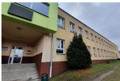
Photo 2. View of the facility Fot. 2. Widok obiektu
