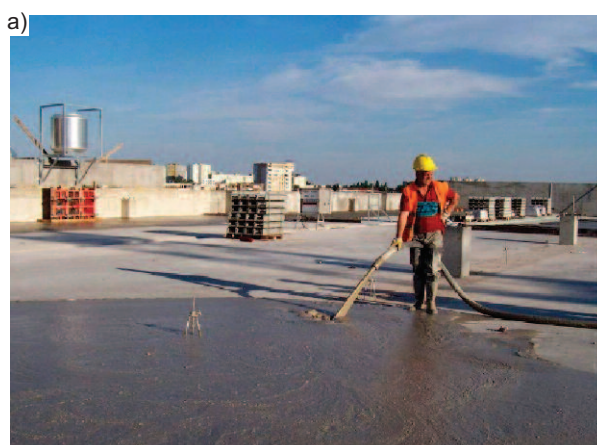
Photo. 1. Laying the foamed concrete mix on the flat roof: a) [13]; b) [14] Fot. 1. Układanie mieszanki pianobetonowej na dachu płaskim: a) [13]; b) [14]
