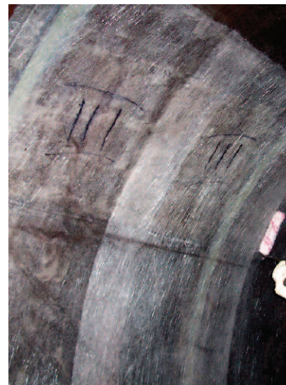
Fot. 3. Nakładanie laminatu poliestrowo-szklanego na wewnętrzną powierzchnię płaszczu zbiornika
