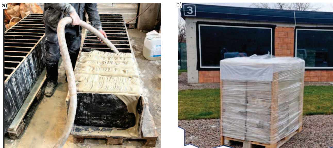
Fot. 2. Produkcja paneli z pianobetonu w RIB (a); panele dostarczone do montażu w Bułgarii (b) Photo 2. Production of foamed concrete panels in RIB (a); panels delivered for installation in Bulgaria (b)
