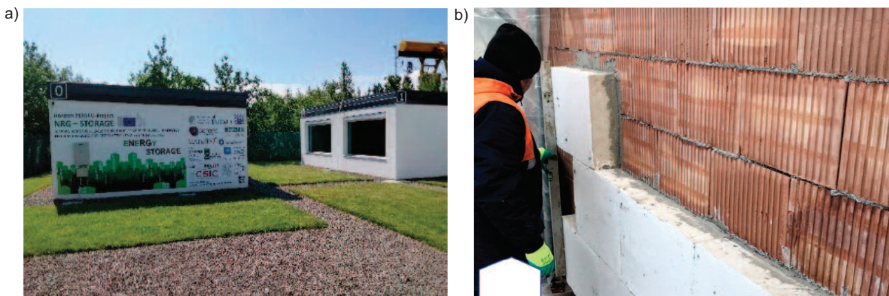
Fot. 1. Budynki demonstracyjne w Bułgarii (a); montaż paneli z ultralekkiego pianobetonu z PCM (b) Photo 1. Demonstration buildings in Bulgaria (a); installation of ultralight foamed concrete panels with PCM (b)
