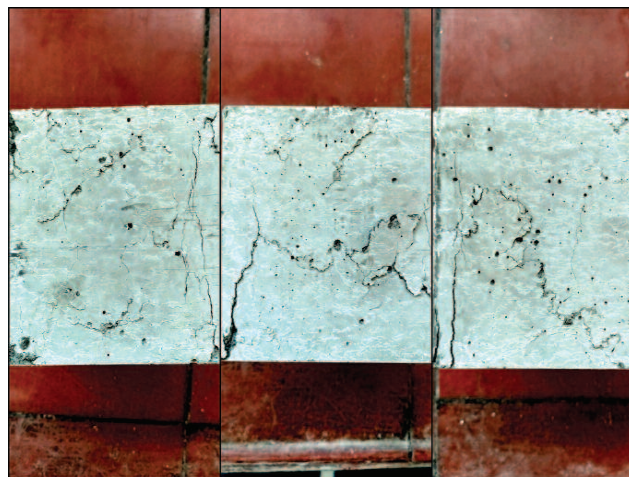
Fot. 2. Przebieg rys w próbkach B0 poddanych oznaczeniu wytrzymałości na ściskanie. Schemat zniszczenia charakterystyczny w przypadku betonu wysokiej wytrzymałości
