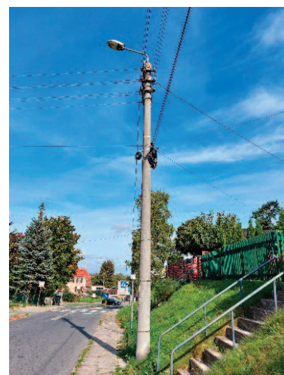
Fot. 2. Widok słupa przelotowego E12/2,5
