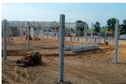
Smukłe słupy żelbetowe Fot. A. Sikorski Slender reinforced concrete columns Photo: A. Sikorski
