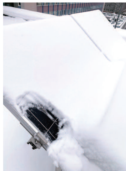
Panele PV w grudniu, lokalizacja: Kraków. 2023 r.
