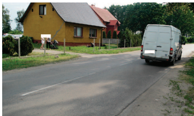
Przykładowy budynek badany pod kątem wpływu drgań wywołanych ruchem drogowym
