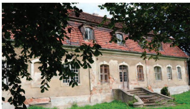
Fot. 2. Elewacja południowa Photo 2. South facade
