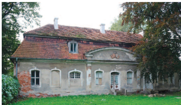
Fot. 1. Elewacja północna Photo 1. North facade
