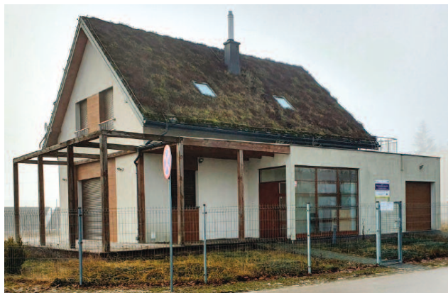
Dom autonomiczny w Podzamczu k. Chęcina, elewacja północno-wschodnia
