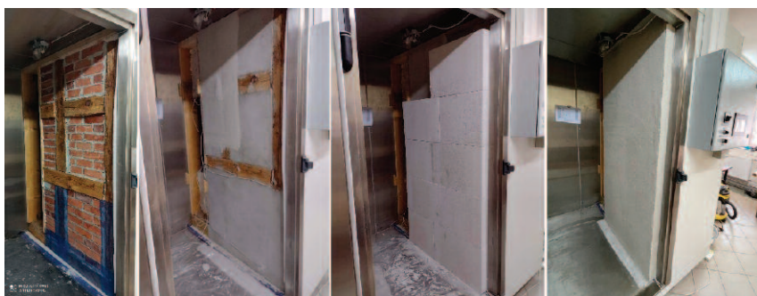
Fot. 2. Etapy wykonywania ściany ryglowej – „mur pruski” w komorze klimatycznej Photo 2. Stages of making the half-timbered wall – „half-timbered wall” in the climatic chamber
