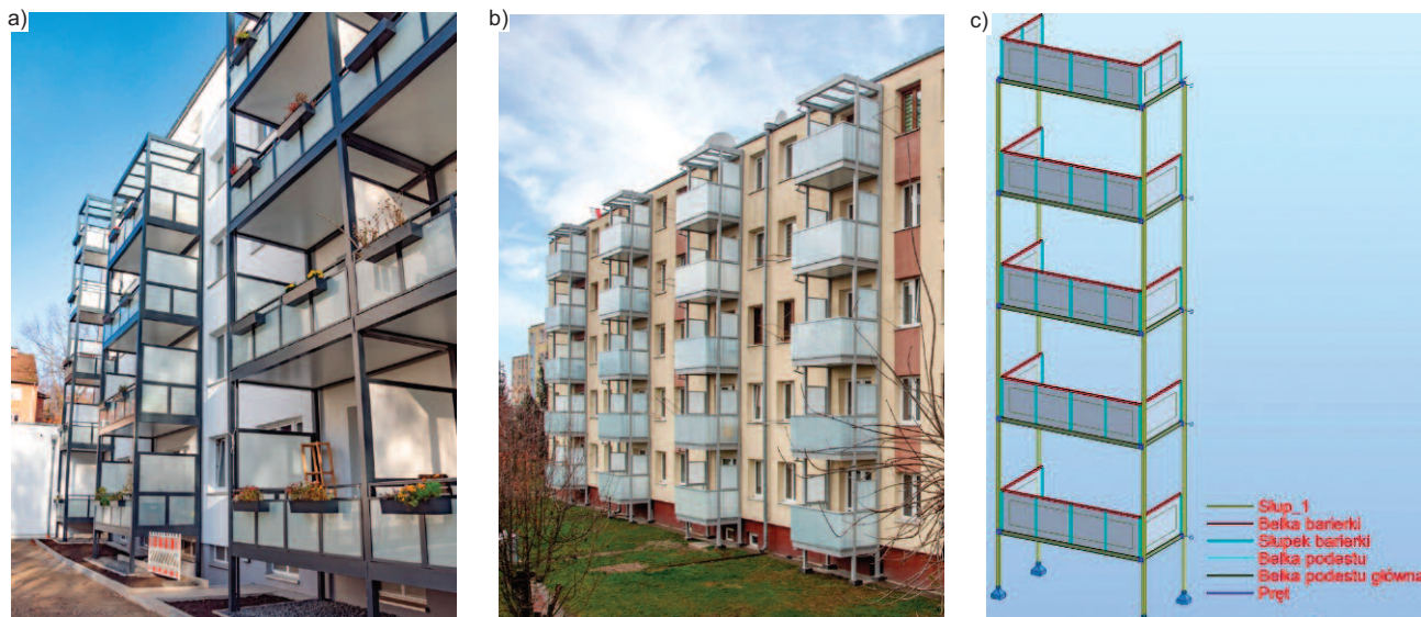
Rys. 1. Balkony dostawne: a) i b) przykładowe realizacje [2]; c) analizowany model Fig. 1. Add-on balconies: a) and b) example implementations [2]; c) analyzed model
