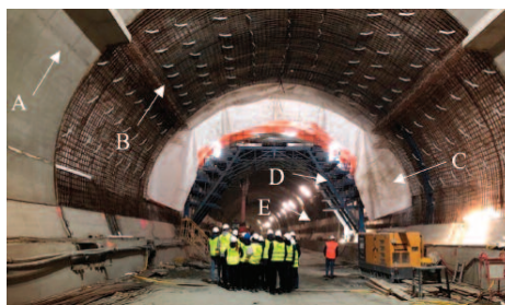
Fot. 1. Obudowa wybranego odcinka tunelu „Luboń Mały” w trakcie wykonywania: A – monolityczna obudowa ostateczna; B – zbrojenie obudowy ostatecznej; C – hydroizolacja; D – ruchome deskowanie obudowy ostatecznej; E – obudowa wstępna
