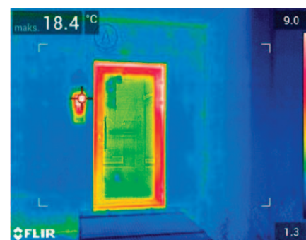
Fot. 6. Zdjęcie termowizyjne drzwi wejściowych umiejscowionych na elewacji południowo-wschodniej budynku D Photo 6. Thermovision image of the entrance door located on the south-eastern facade of building D
