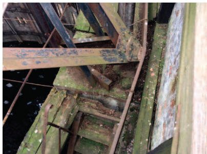
Fot. 6. Utlenienie się stali na więzarach dachowych Fot. materiały od inwestora Photo 6. Oxidation of steel on roof trusses Photo by Investor archive
