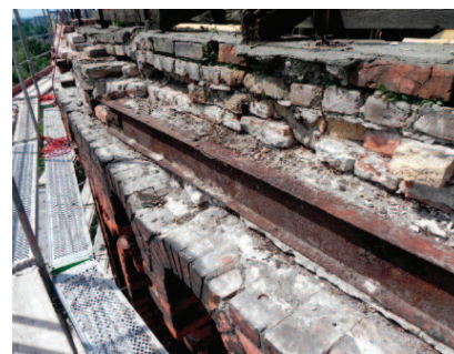
Fot. 7. Wżery rdzy na belce w gzymsie Fot. materiały od inwestora Photo 7. Rust pits on the beam in the cornice Photo by Investor archive
