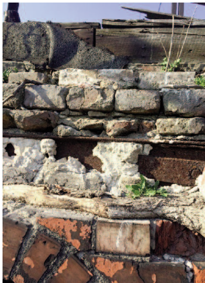
Fot. 5. Korozja biologiczna cegieł i zaprawy oraz stalowego elementu obwodowego Fot. materiały od inwestora Photo 5. Biological corrosion of bricks and mortar and steel peripheral element Photo by Investor archive
