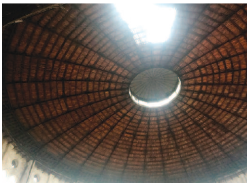
Fot. 4. Konstrukcja dachu wraz ze świetlikiem Fot. archiwum autorów Photo 4. Roof construction with skylight Photo by authors archive
