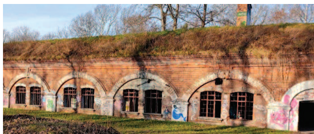
Fot. 1. Elewacja zewnętrzna koszarów prawych Fot. M. Muchorowska Photo 1. External elevation of the right barracks Photo M. Muchorowska
