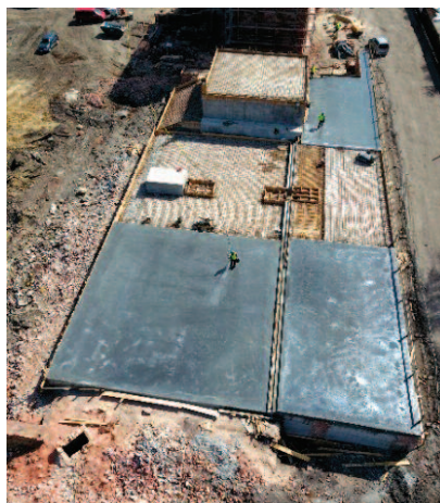
Fot. 4. Dylatacje płyty stropodachu Photo 4. Dilatation flat roof slab
