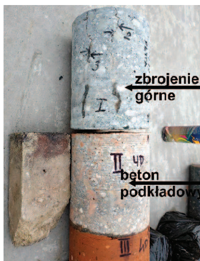
Fot. 6. Odwiert rdzeniowy przez płytę stropodachu i beton podkładowy – otulina zbrojenia górnego ma 17 cm
