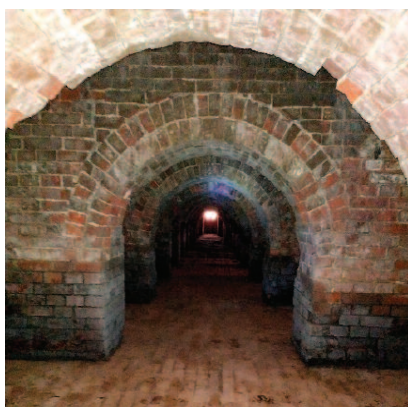
Fot. 2. Sklepienia kolebkowe i korytarz Photo 2. Barrel vaults and the corridor
