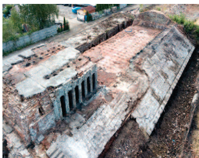
Fot. 1. Bateria pieców koksowniczych: widok z góry na oczyszczony strop ceglany Photo 1. Battery of coke ovens: top view for the cleaned brick ceiling
