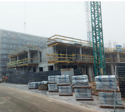
Budowa osiedla budynków wielorodzinnych w Lublinie Fot. M. Rogalska Multi-family housing estate under construction in Lublin Photo M. Rogalska
