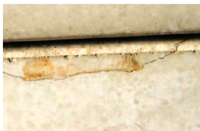
Fot. 4. Rysy w płytach Filigran stropu poziomu +3,00 od uderzenia o podporę tymczasową. Położenie rys oznaczono literą „D” na rysunku 2
