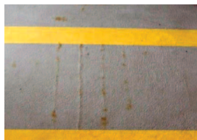
Fot. 2. Rysy w obszarach przysłupowych. Położenie rys oznaczono literą „B” na rysunku 2
