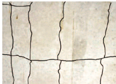
Fot. 3. Rysy tworzące siatkę na dolnej powierzchni stropu poziomu +3,00. Położenie rys oznaczono literą „C” na rysunku 2
