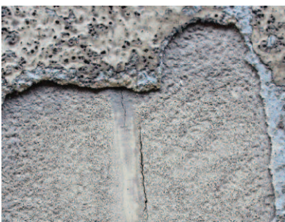
Fot. 1. Rozwój rysy naprawionej na górnej powierzchni stropu poziomu +3,00. Położenie rysy oznaczono literą „A” na rysunku 2
