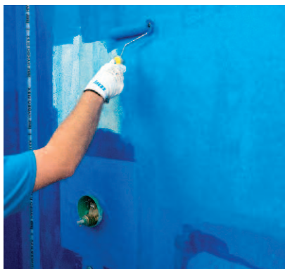
Zabezpieczenie powierzchni tynku gipsowego płynną folią i elastycznymi taśmami uszczelniającymi
