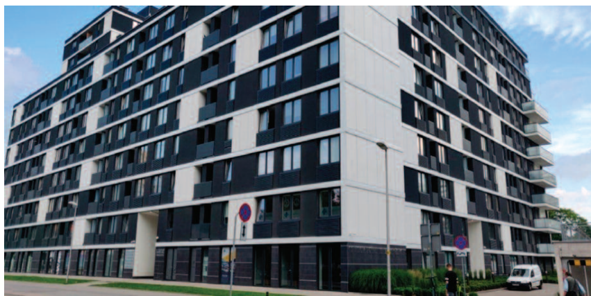
Elewacja zachodnia i południowa budynku o konstrukcji szkieletowej West and south façade of the building with a frame structure
