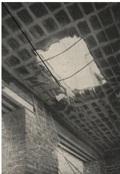
Fot. 2. Próbne obciążenia stropów z początku XX wieku [1] Photo 2. Test loads on ceilings at the beginning of the 20th century [1]
