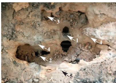
Fot. 3. Widok z góry odkrywki stropu nad piwnicą: 1) pręt zbrojenia podłużnego (Ø16 mm); 2) pręt zbrojenia poprzecznego (Ø18 mm); 3) rulon kartonu; 4) beton krzyżowych żeber stropu; 5) pustak ceramiczny
