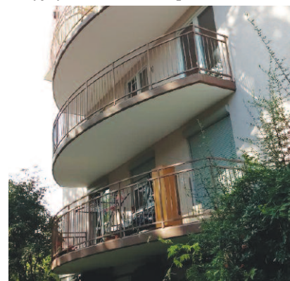
Fot. 2. Elewacja analizowanego budynku Photo 2. Elevation of the analysis building
