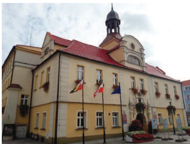
Fot. 3. Elewacja frontowa ratusza w Żarach [8] Photo 3. Facade of the Zary Town Hall [8]
