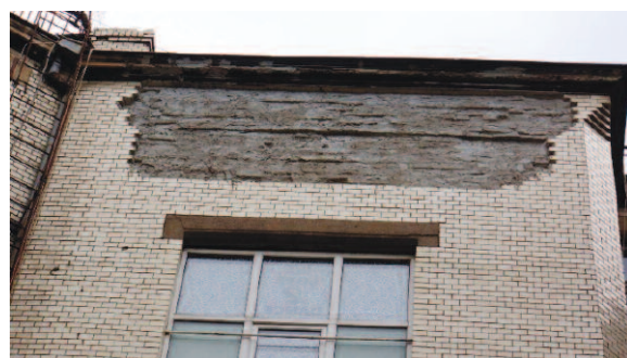
Fot. 2. Duże ubytki okładziny licowej ściany elewacji wschodniej dziedzińca, widok przed rozpoczęciem prac rewaloryzacyjnych
