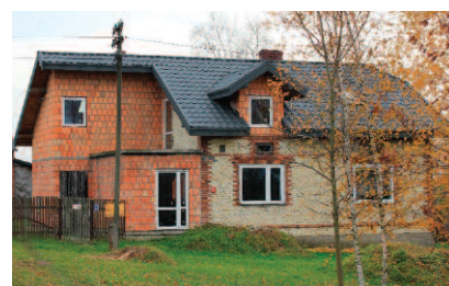
Fot. 4. Rozbudowa budynku przed termomodernizacją
