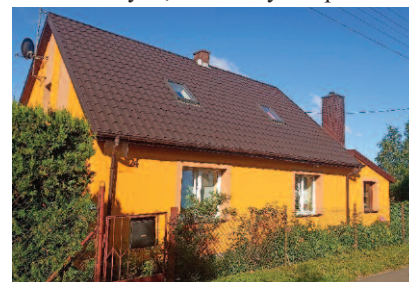
Fot. 3. Efekt kompleksowego remontu budynku z kamienia wapiennego
