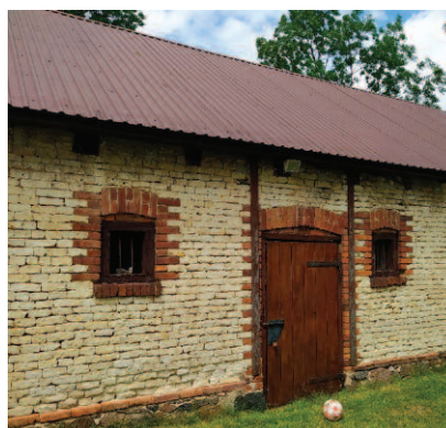
Fot. 2. Budynek inwentarski po wymianie pokrycia dachowego
