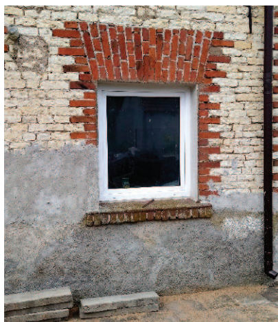
Fot. 7. Przykład doraźnych napraw
