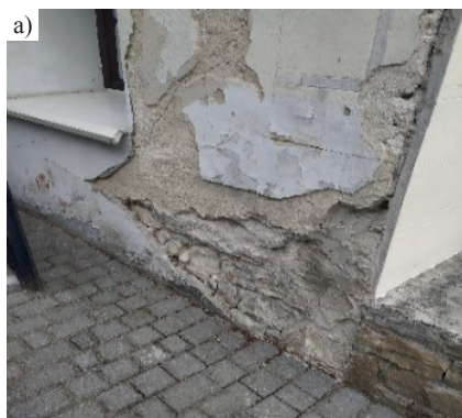
Fot. 2. Skutki negatywnego wpływu wilgoci na mury spichlerza: a) naroże budynku; b) korozja cokołu; c) pęknięcie muru [20.05.2005 r.]
