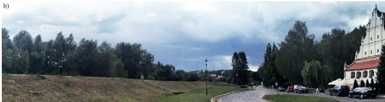
Fot. 1. Budynek spichlerza w Kazimierzu Dolnym: a) front budynku; b) położenie budynku i wału nad Wisłą [20.06.2022 r.]
