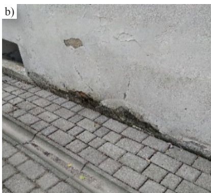
Fot. 2. Skutki negatywnego wpływu wilgoci na mury spichlerza: a) naroże budynku; b) korozja cokołu; c) pęknięcie muru [20.05.2005 r.]
