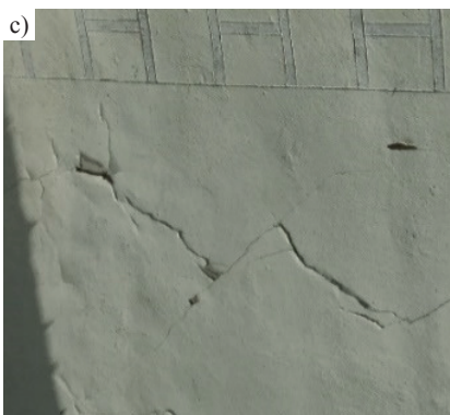
Fot. 2. Skutki negatywnego wpływu wilgoci na mury spichlerza: a) naroże budynku; b) korozja cokołu; c) pęknięcie muru [20.05.2005 r.]
