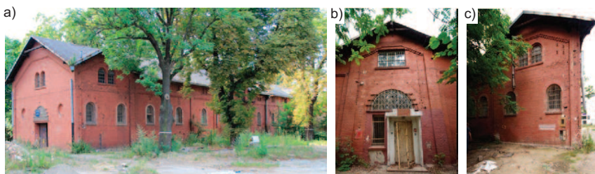
Fot. 1. Stajnia nr 3, stan 2020 r.: a) północna i wschodnia elewacja; b) przebudowany fragment elewacji południowej; c) skrajna część elewacji południowej Fot. P. Kirschke Photo 1. Stable No. 3, 2020: a) North and East Elevation; b) rebuilt section of South Elevation; c) extreme part of South Elevation Photo P. Kirschke
