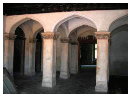
Fot. 2. Fragment parteru, zachowane zdobione główce arkad i oryginalne tynki kolumn Photo 2. Fragment of ground floor, preserved decorated arcade heads and original plaster of columns
