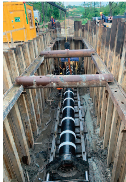
Przykład zabudowy gazociągu wysokiego ciśnienia – rury stalowe Fot. S. Kosmański An example of high pressure gas pipeline installation – steel pipes Photo S. Kosmański
