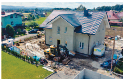
Fot. 1. Jednorodzinny budynek mieszkalny, wzniesiony z prefabrykatów ze styrobetonu Photo 1. Single-family house made with the use of precast EPS concrete units
