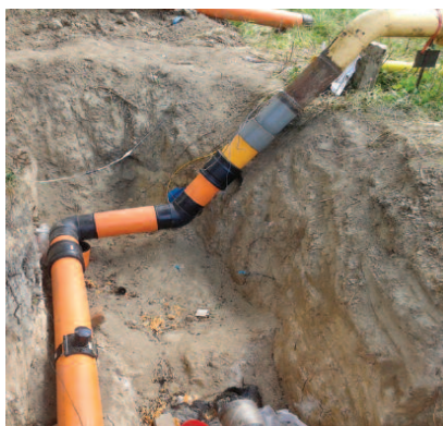
Przykład zabudowy gazociągu niskiego ciśnienia – rury polietylenowe
