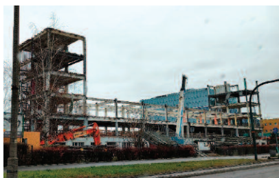
Fot. 1. Rozbiórka obiektu biurowo-usługowego w Krakowie przy ulicy Wadowickiej, 01.12.2021
