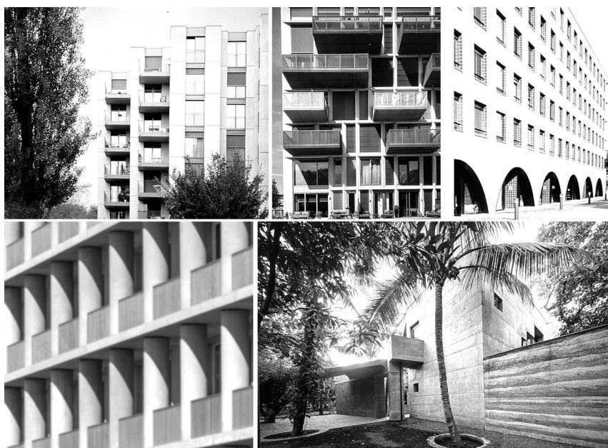
Zespół zabudowy w Boveresses. Sketchblock. Pasodoble. Betonhaus. House of Concrete Experiments Opracowanie własne Building complex in Boveresses. Sketchblock. Pasodoble. Betonhaus. House of Concrete Experiments Own study
