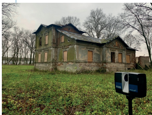
Photo 1. Mansion in Kliczewo Małe with a Faro laser scanner in the front Fot. 1. Dwór w Kliczewie Małym ze skanerem laserowym Faro na pierwszym planie
