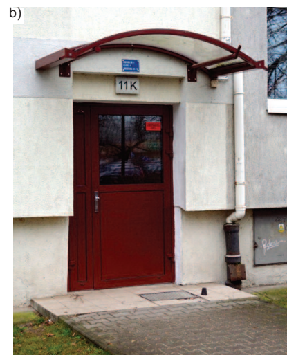
Fot. 1. Pierwotne (a) i nowe (b) rozwiązanie daszku nad wejściem do klatki pięciokondygnacyjnego budynku
