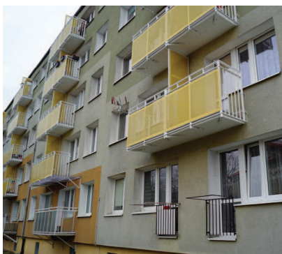
Fot. 3. Przykład wyremontowanego balkonu z wprowadzoną nową balustradą zamocowaną do spodu płyty
