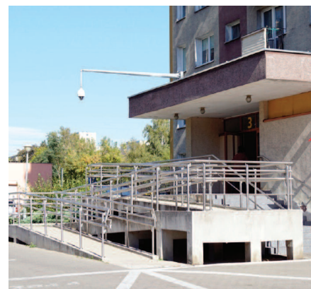
Fot. 2. Widok pochylni dobudowanej do budynku wysokiego
