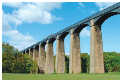
Fot. 1. Akwedukt w Pontcysyllte [6] Photo 1. Pontcysyllte aqueduct [6]
