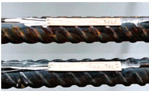
Fot. 1. Rozmieszczenie czujników tensometrycznych na zbrojeniu
